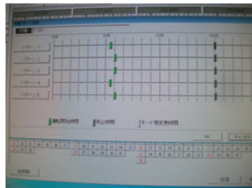
冷暖房(と換気?)スケジュール設定;6時半から起動
