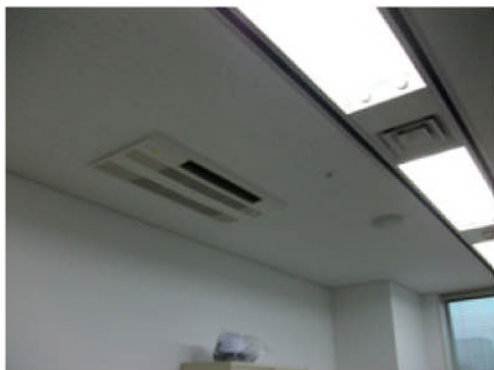
天井点検口;設置されていない箇所が多くある。ドレン関係点検、保全(詰まり対応)等が不可能
