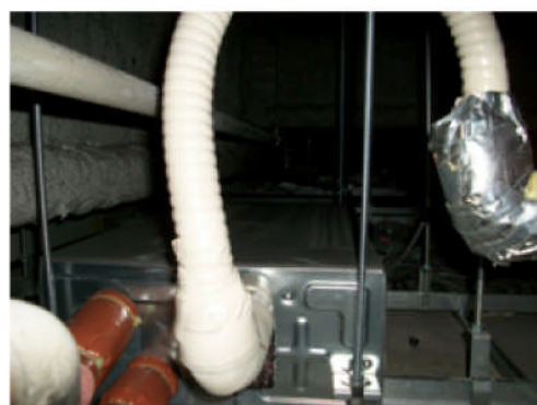
天井点検口;設置されていない箇所が多くある。ドレン関係点検、保全(詰まり対応)等が不可能
