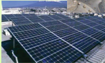
【太陽光発電設備】
