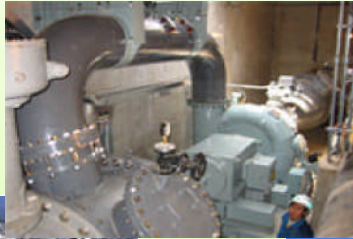
【水力発電設備】
