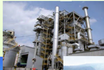
【バイオマス発電設備】
