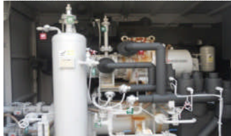
冷凍機ユニット
