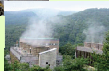
【地熱発電設備】
