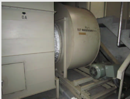
地下給排気ファン
