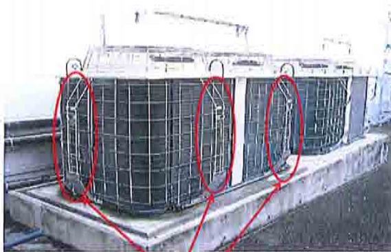
水噴霧装置の設置状況
