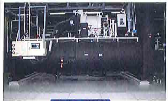
高効率ターボ冷凍機
