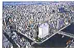
②箱崎地区 (河川水利用)
