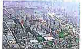
⑥光が丘団地 (清掃工場廃熱利用) 26
