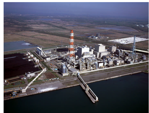
苫東厚真発電所全景
