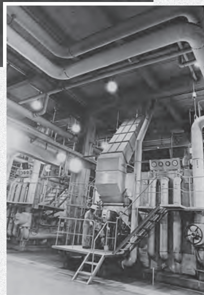
高温水ボイラー
